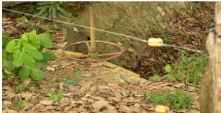
Imagen 8. Control de ingreso de agua desde el río Sinú a la Ciénaga
