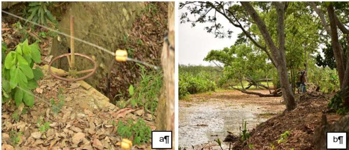
Imagen 1. a. Control del ingreso de agua del río Sinú, b. Dique construido y paralelamente caño de drenaje.
